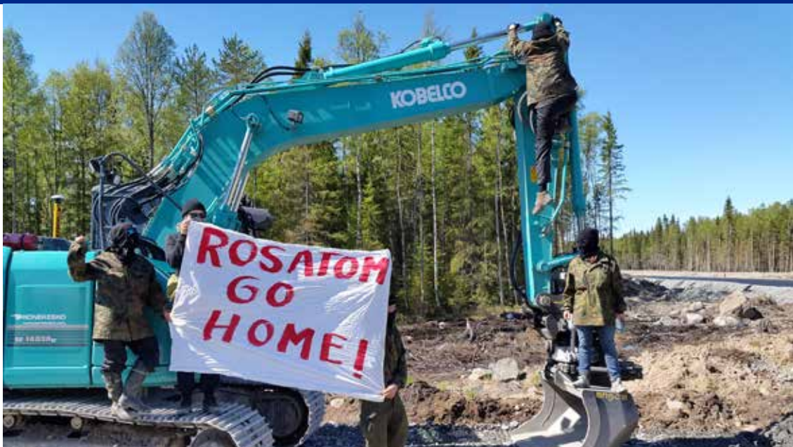
Протестующие заблокировали экскаватор на площадке строительства АЭС «Ханхикиви».
