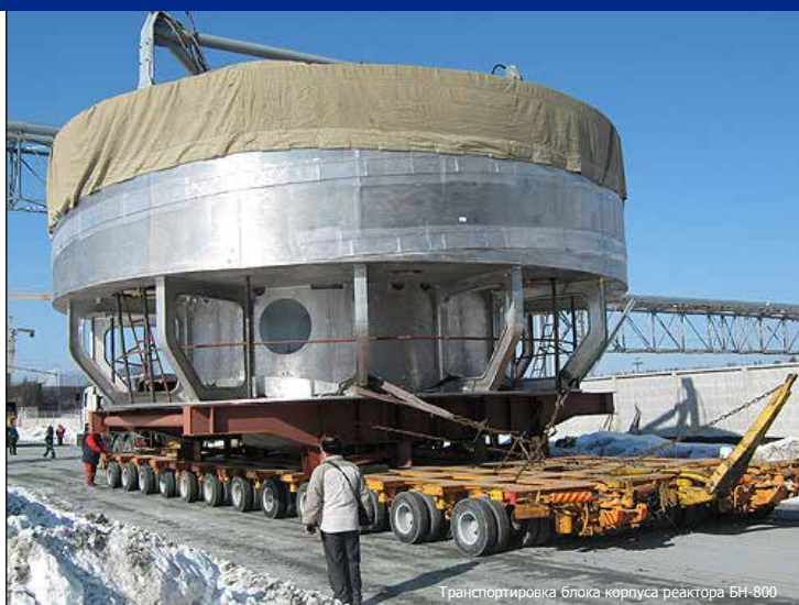
Транспортировка блока корпуса реактора БН-800
